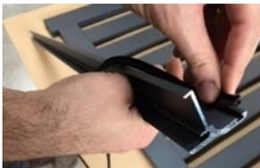
2. Présenter le battement dans le montant de gâche. Il se clippe. Le battement doit être positionné sous le chapeau du montant de gâche.
