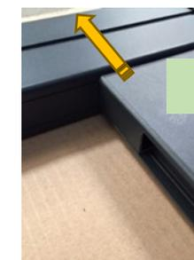
15. Clipper le capot de montant 21 x 9 mm sur le montant d'extrémité.
