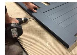
15. Procéder de la même façon pour le montant côté refoulement, au préalable caler sous la traverse haute et basse.
